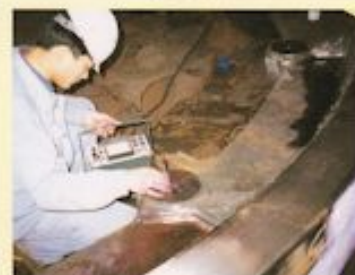
現地UT検査
