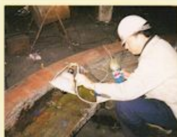
現地MT検査
